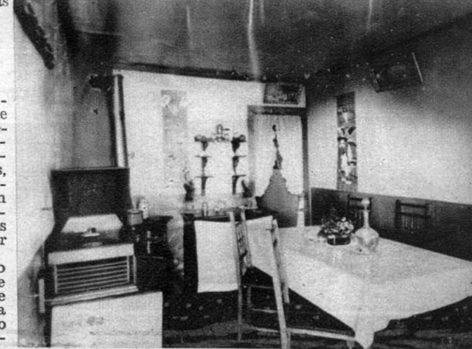
Interior de una habitación para obreros. Puede apreciarse el orden y la limpieza que hay en ella. Braden Copper vela por su buen mantenimiento.
