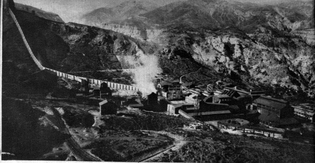
Caletones a vista de pájaro. En esta fundición se hace una de las faenas más interesantes de la mina.
